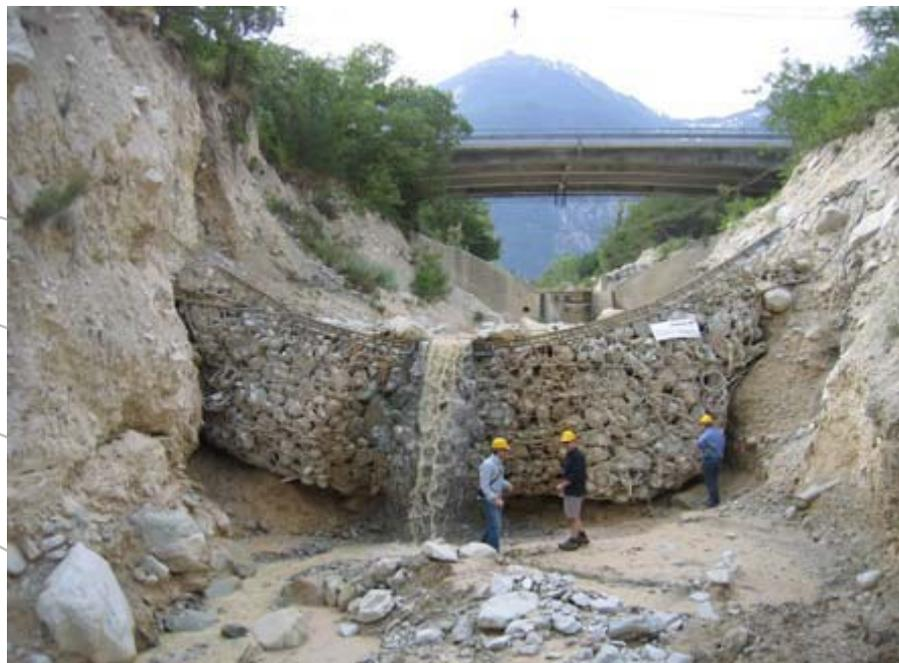
**Foto 3:** Vista de barreira de proteção posteriormente a ocorrência de debris flow.
