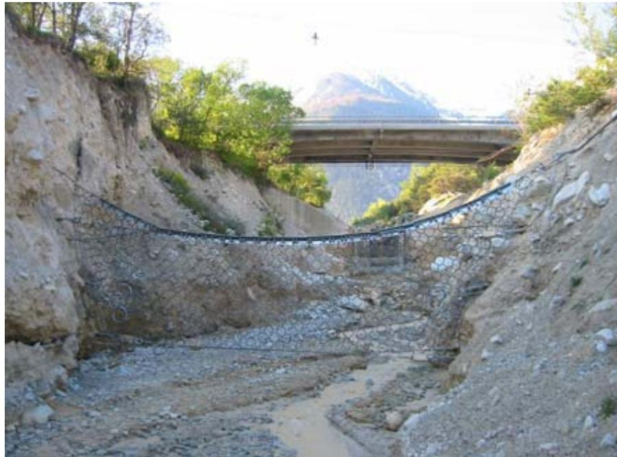
**Foto 2:** Vista de barreira de proteção instalada.
